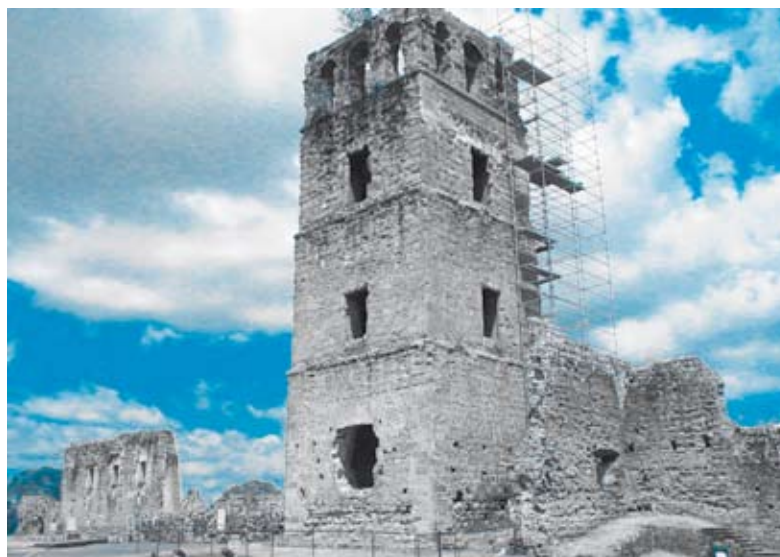
REHABILITACIÓN DE LA TORRE
