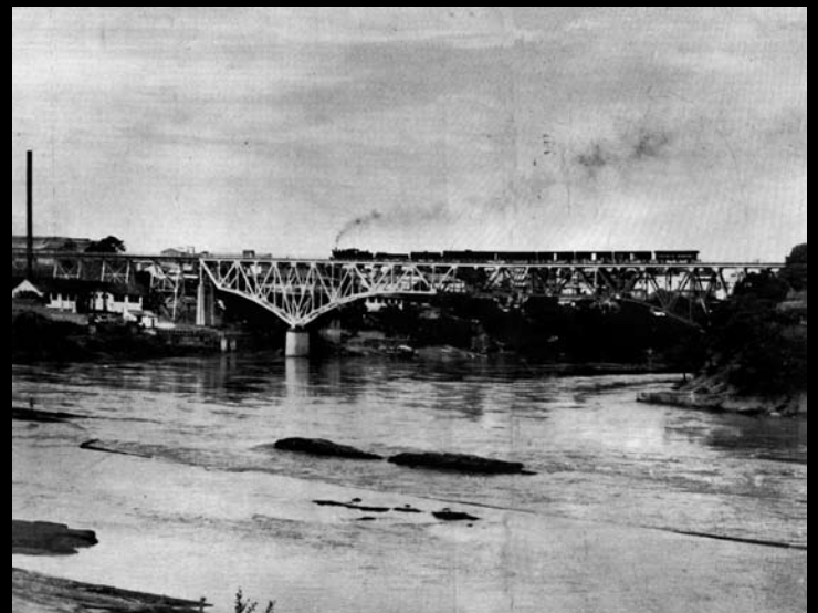
GIRARDOT, UNO DE LOS PUERTOS FLUVIALES MÁS IMPORTANTES, SE UNE AL DEPARTAMENTO DEL TOLIMA, ENTRE OTROS, POR ESTE PUNTE DE ARMÓNICA ARQUITECTURA, CON LÍNEA FERROVIARIA Y VÍAS PARA LOS PEATONES QUE ADMIRAN DESDE EL, EN SUS PASEOS VESPERTINOS, EL HERMOSO PANORAMA DEL RÍO MAGDALENA
